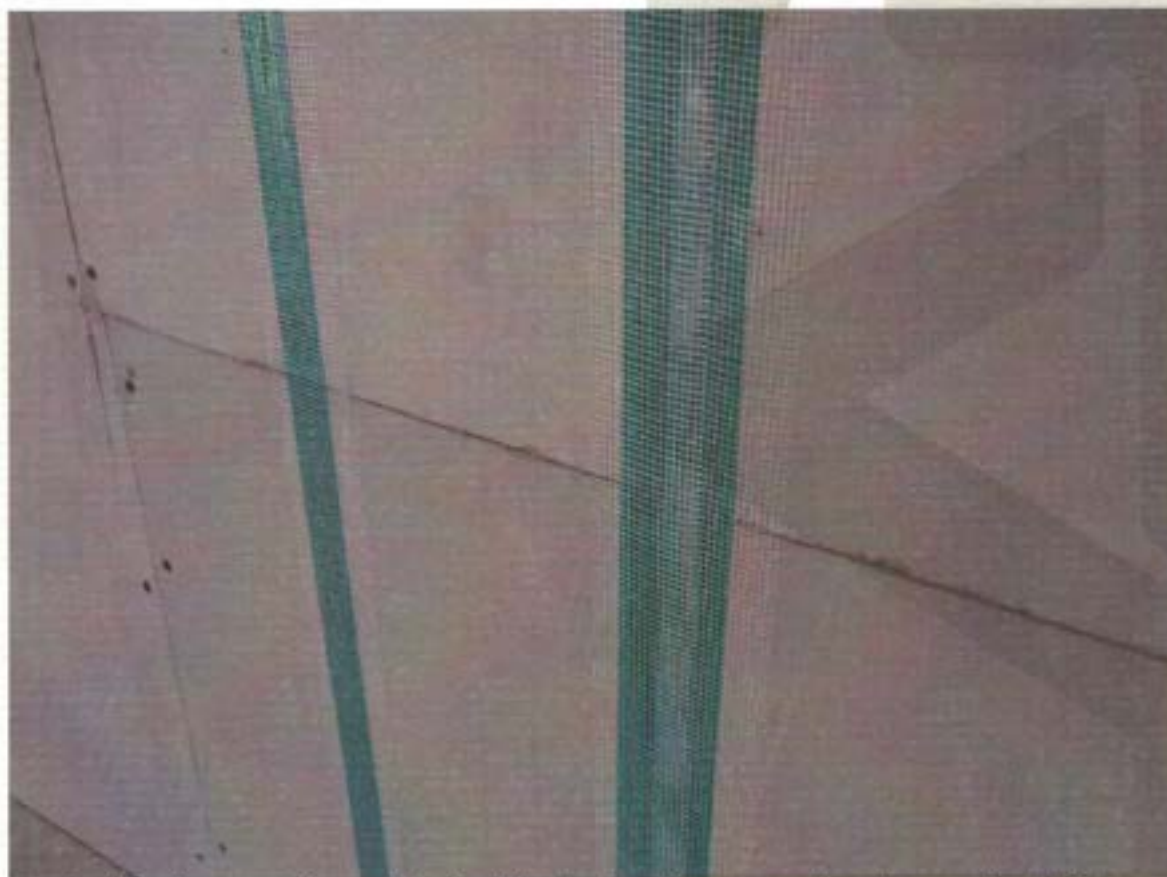
Foto 2: Applicazione nastri conduttori sullo strato esterno – applicazione nastro di rinforzo per cartongesso
